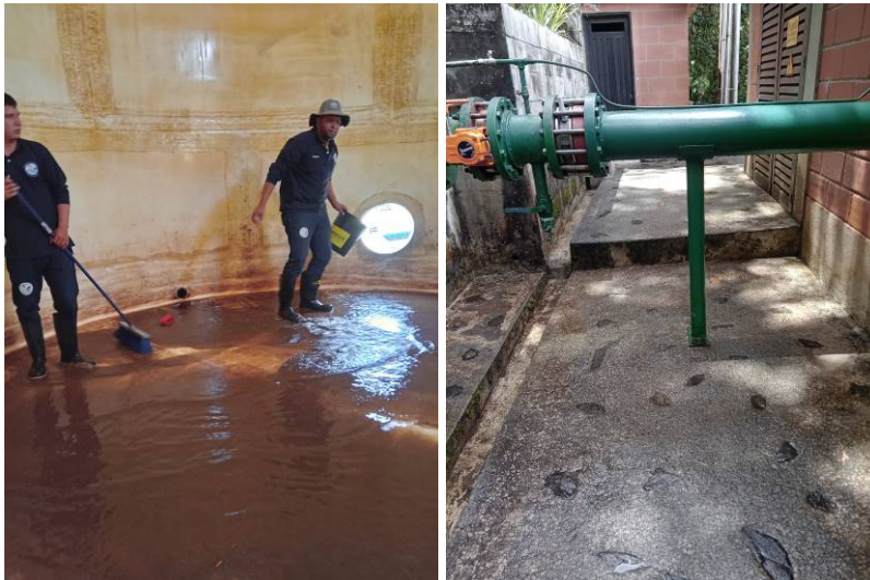
Foto No. 5. Mantenimientos Caseta de Bombas agua cruda
