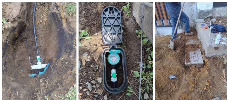
Foto No. 12. Colocaciones acometidas
