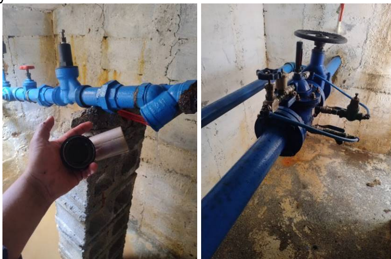
Foto No. 4. Mantenimientos válvulas reguladoras
