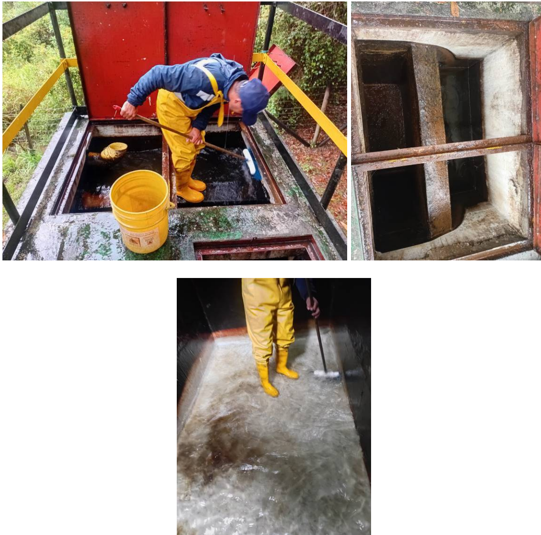
Foto No. 7. Mantenimientos desarenador y tanque succión
