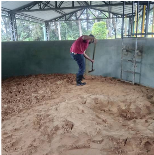
Foto No. 8. Mantenimientos filtros lentos
