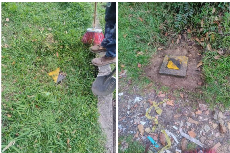
Foto No. 3. Mantenimientos hidrantes
